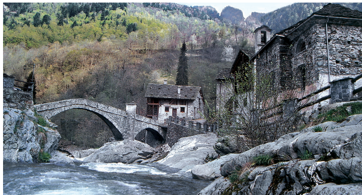
RASSA - PONTE IN PIETRA
